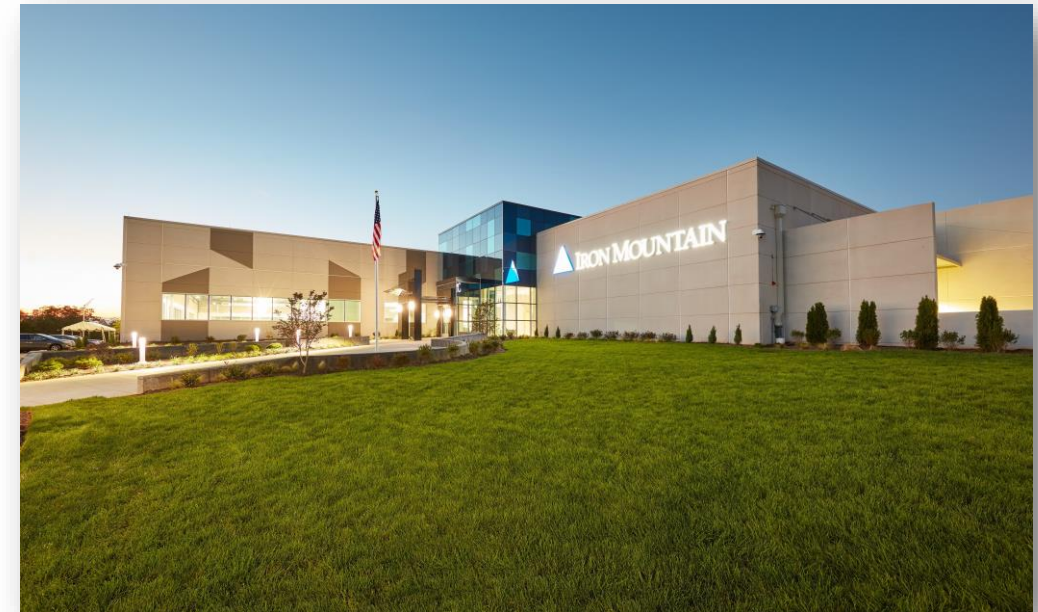
VA-1 Data Center
